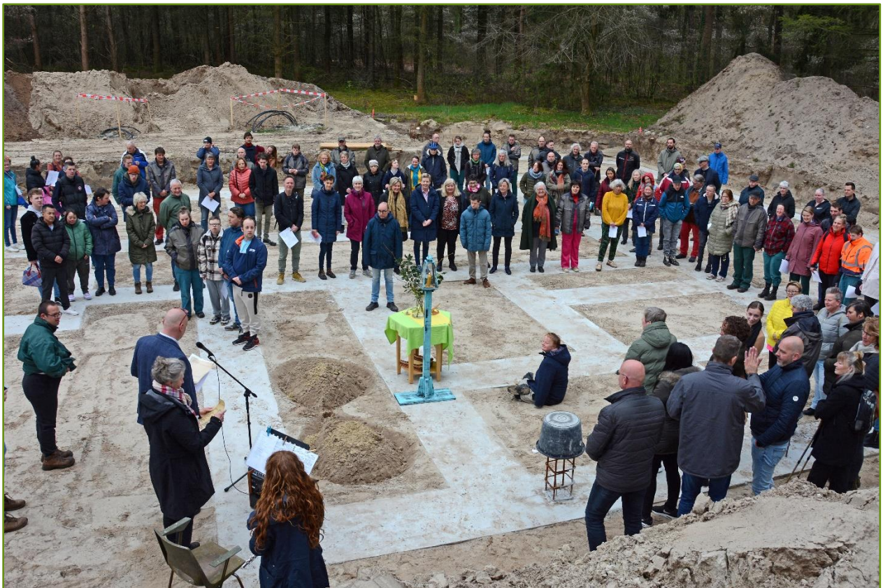
Op het fundament van het nieuwe woonhuis de Platanus wordt de grondsteenspreuk van OlmenEs gesproken. In april 2024 is het gebouw klaar om bewoond te worden.
